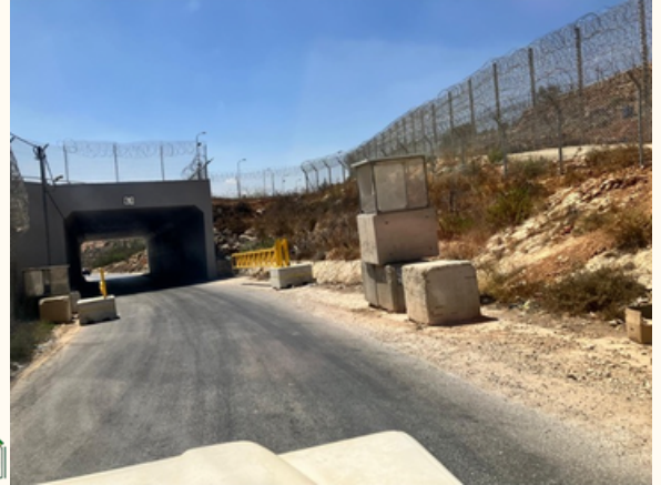
Barriere, jetzt geöffnet, auf der Strasse zum Weinberg
